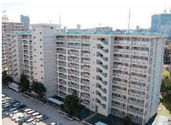
耐震改修されたマンション
