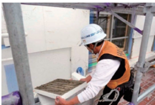
壁の外断熱工事
