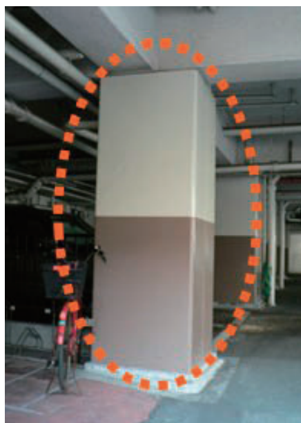
柱の補強（鋼管巻き補強） （昭和 45(1970)年築）
