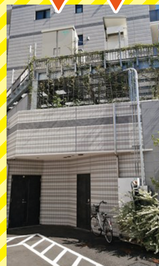
浸水に備えた設置状況
