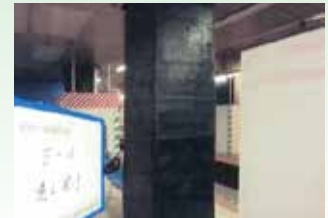
炭素繊維補強完了
