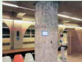
既存躯体目荒し
