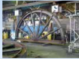
車輪型ブレース製作状況
