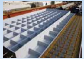
鋼板耐震壁製作状況
