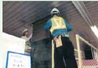
炭素繊維シート巻き付け
