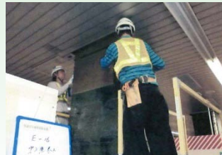
炭素繊維シート巻き付け
