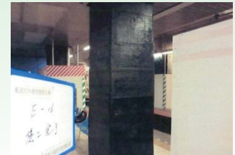
炭素繊維補強完了
