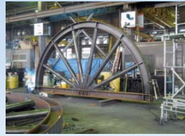
車輪型ブレース製作状況
