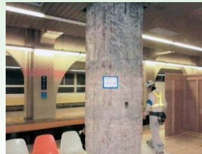
既存躯体目荒し
