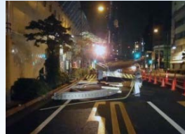
車輪型ブレース現場搬入
