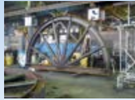
車輪型ブレース製作状況
