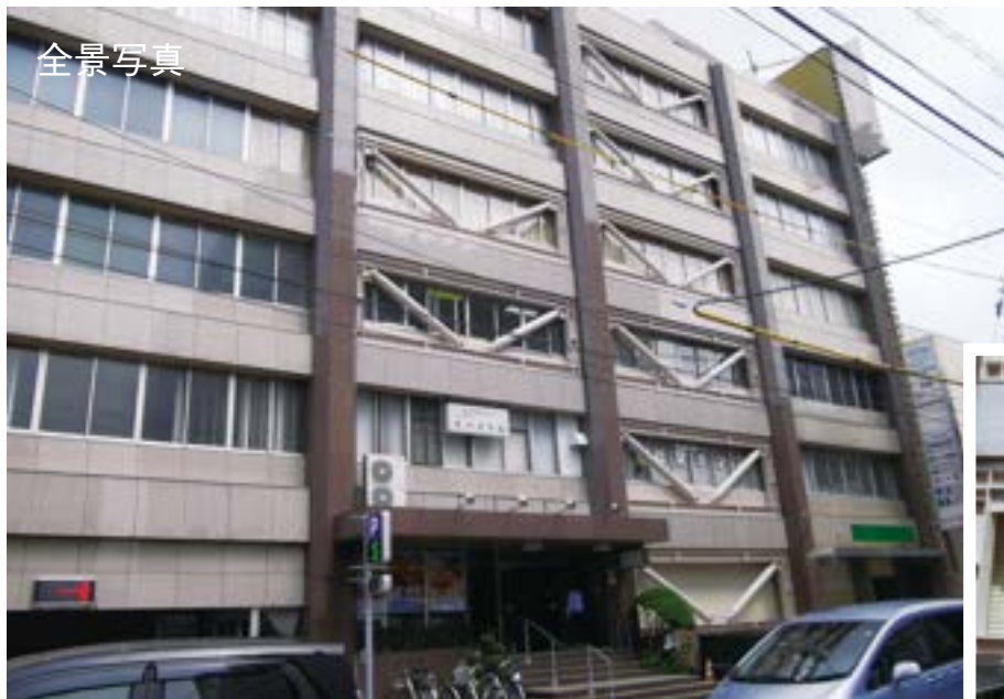
A D座屈拘束ブレース写真
