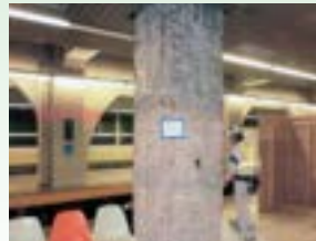
既存躯体目荒し
