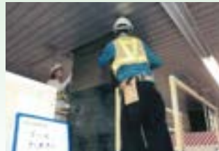
炭素繊維シート巻き付け
