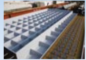
鋼板耐震壁製作状況
