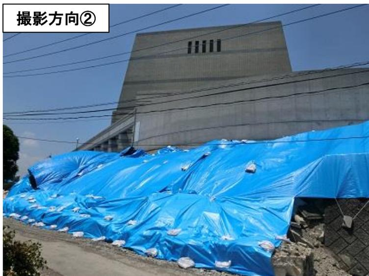
建物南東側の土留壁が崩壊・・・上部構造は無被害だが、建物が傾斜（杭も損傷か？）
