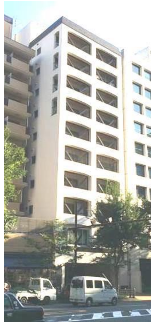
マンションにおける 鉄骨ブレース補強例
