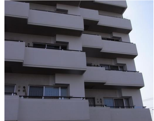
外付け柱補強例
