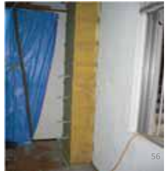
外付け柱補強例
