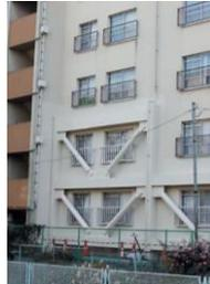
軽量のアルミブレースを外付け、重機不要で低騒音施工
