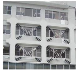
工場製作の部材を用いて工期短縮、ブレースが細く採光を妨げない
