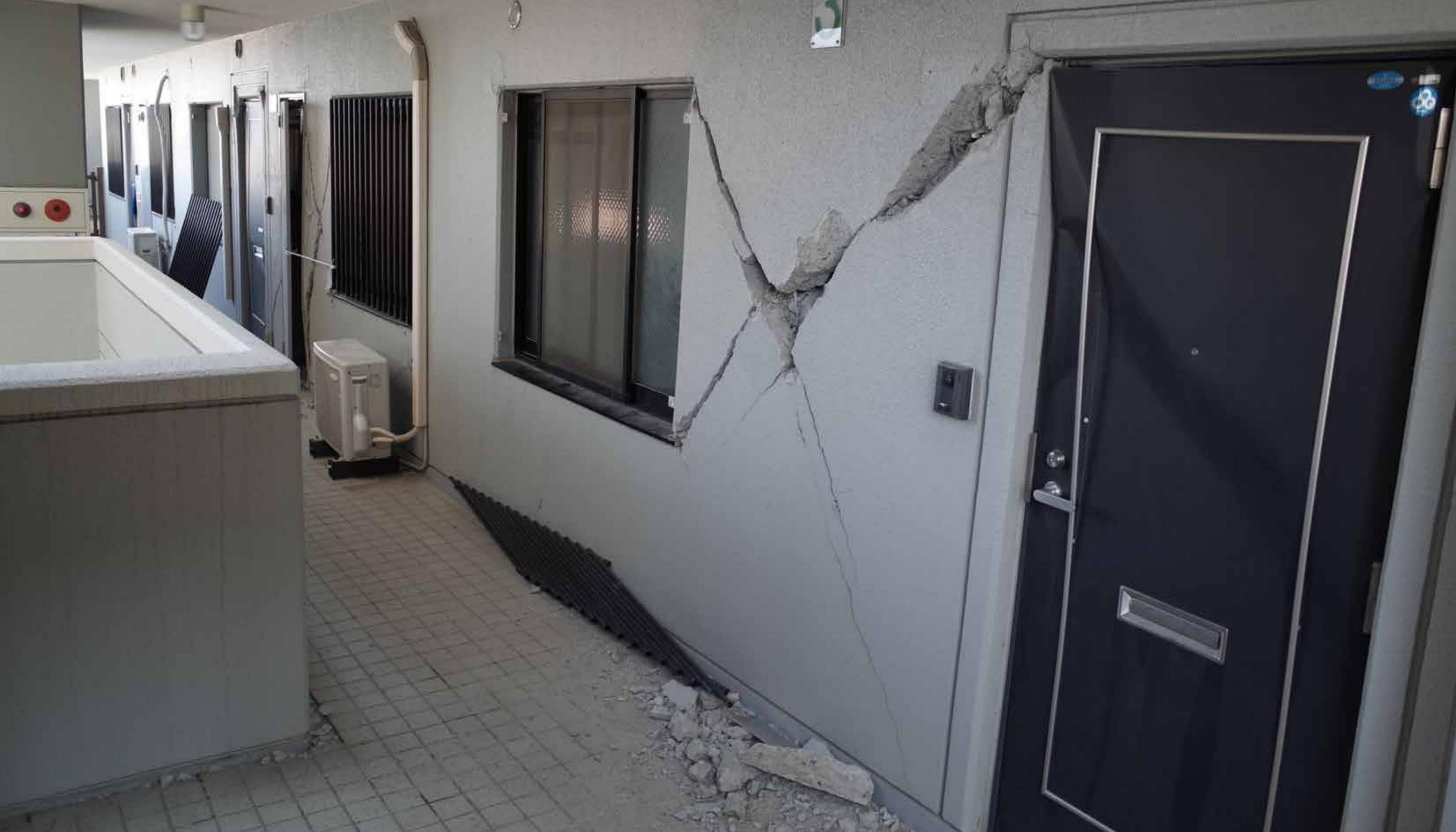
非耐震壁の損傷と玄関扉の変形
