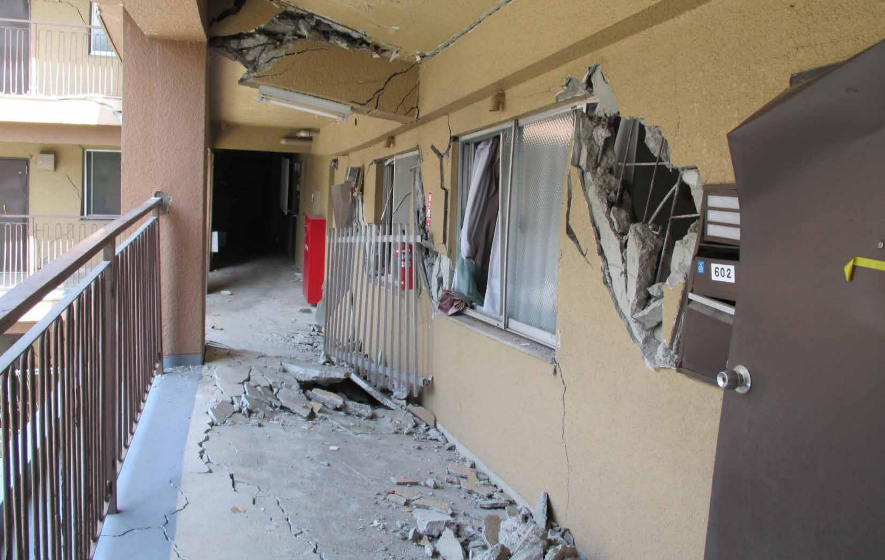
共用廊下壁、梁の損傷、玄関扉の変形
