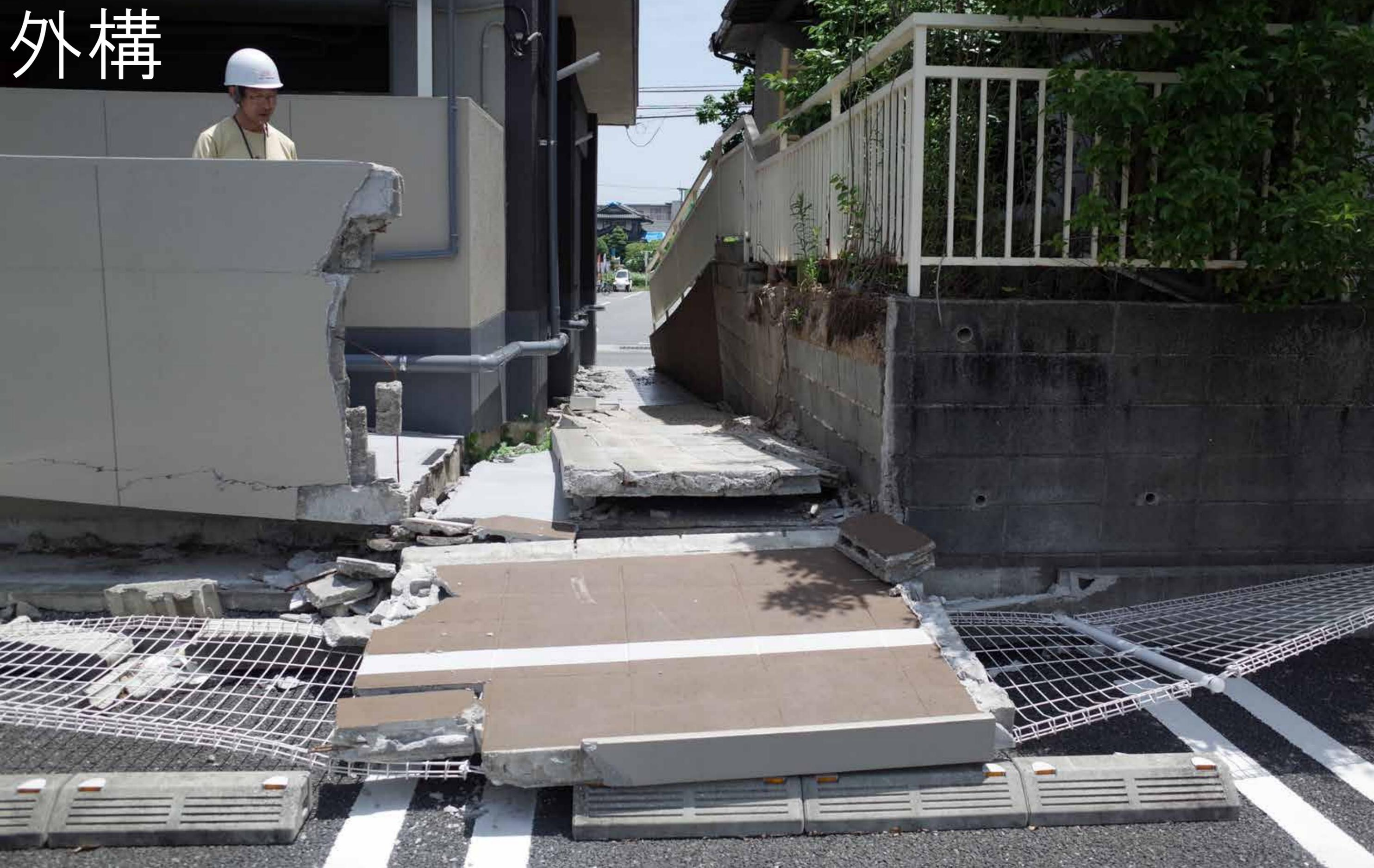
外構コンクリートブロック塀、擁壁の倒壊
