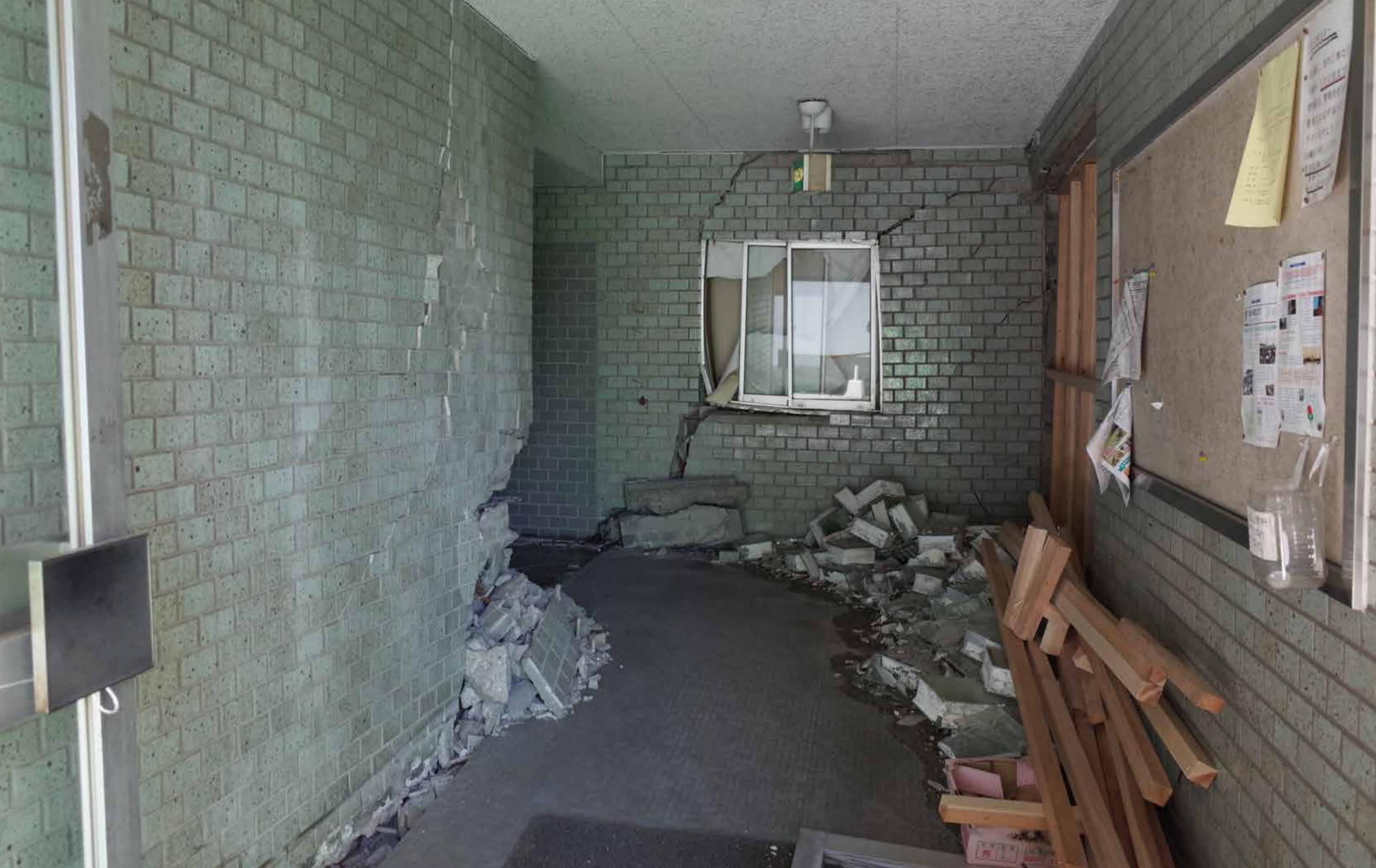
エントランスホールの壁破損、仕上タイルの剥落
