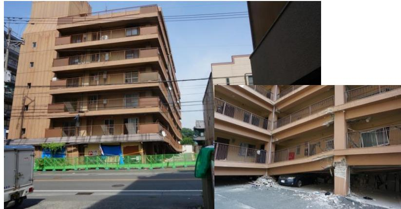
前震で損傷・本震後に崩壊
