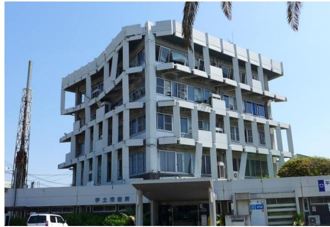
宇土市役所：4階が崩壊(宇土市：震度6強)
