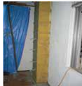
外付け柱補強例
