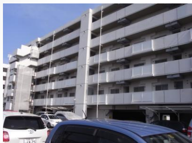
繊維シートによる補強例
