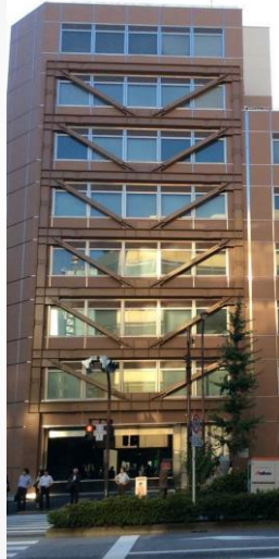
事務所ビルにおける 鉄骨ブレース補強例
