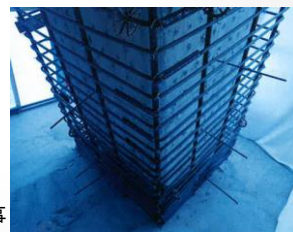
柱配筋工事
