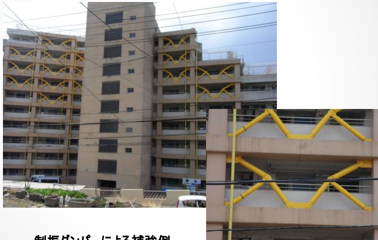
制振ダンパーによる補強例
