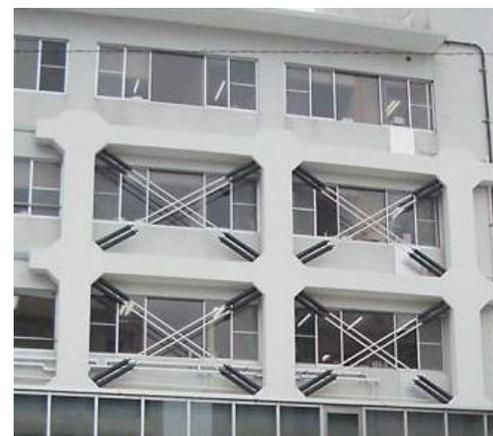
工場製作の部材を用いて工期短縮、ブラースが細く採光を妨げない
