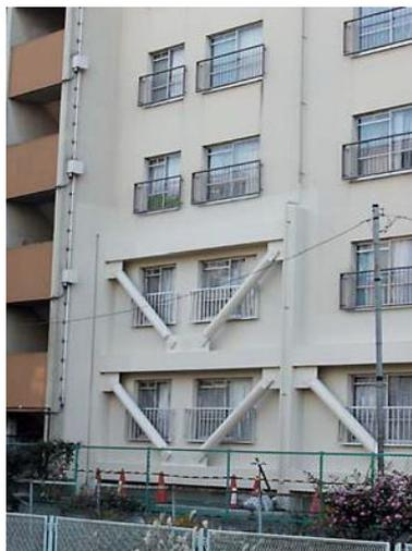
軽量のアルミブラースを外付け重機不要で低騒音施工
