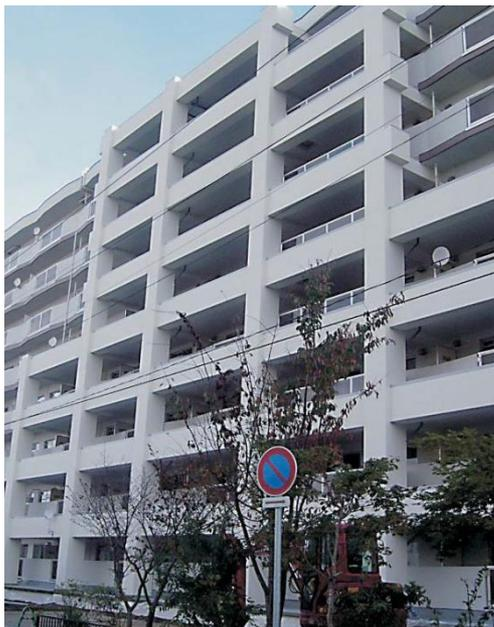
外付け補強フレームを既存バルコニーの撤去無しに設置、開口部を遮蔽しない
