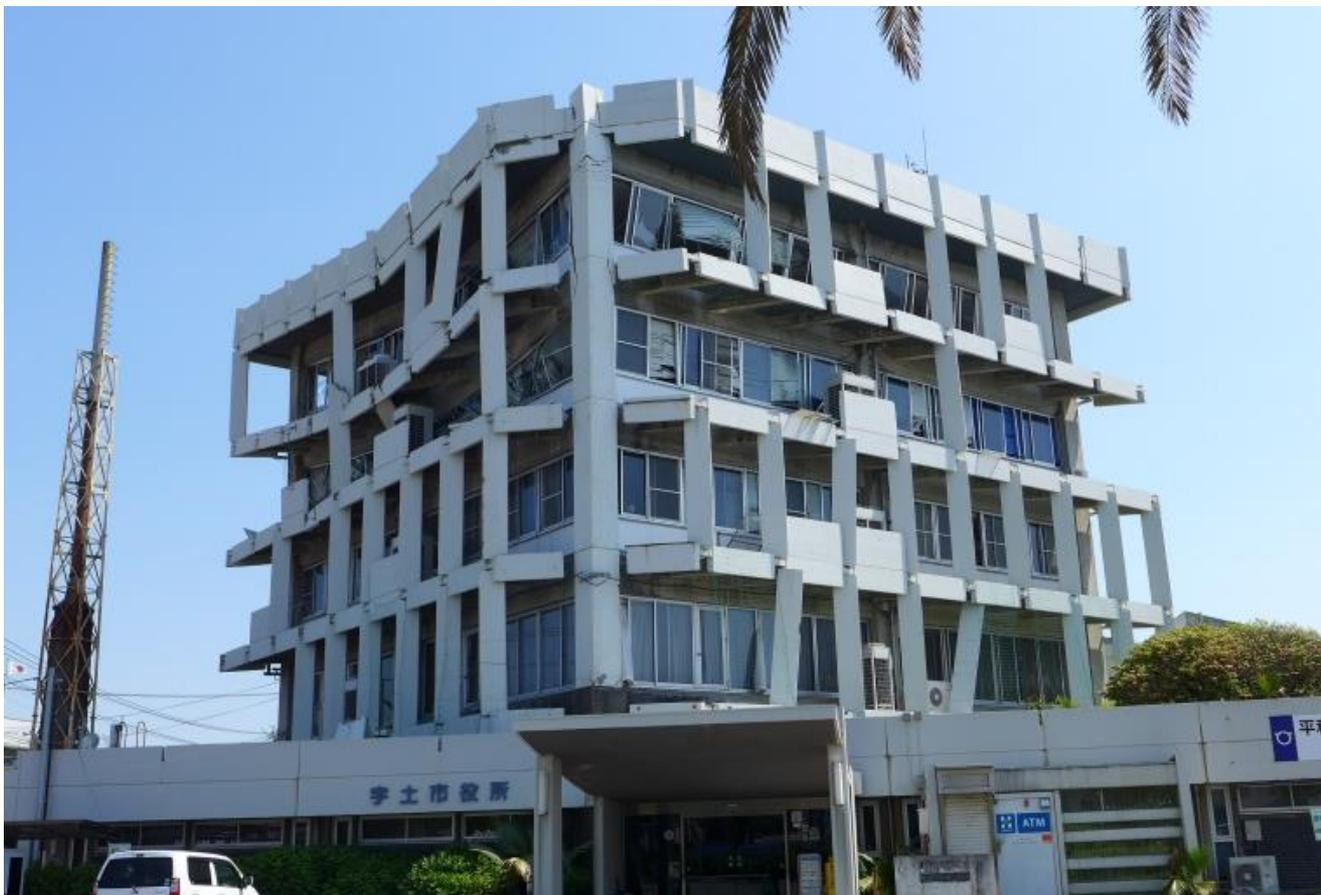
宇土市役所：4階が崩壊(宇土市：震度6強)
