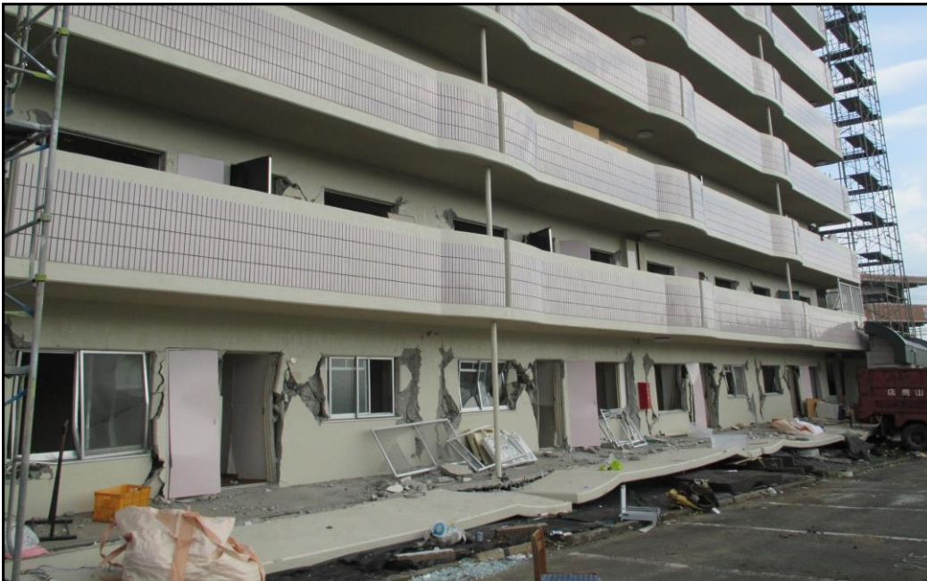
共用廊下非耐震壁の損傷熊本地震
