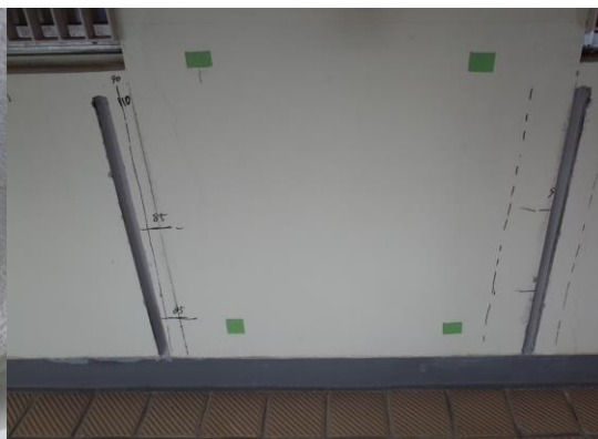
耐震スリット設置後、仕上げ前の状況
