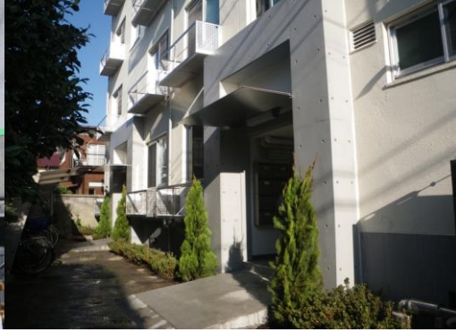
他事例の写真 エントランスにコンクリートのフレームを設置した例 (改修後)
