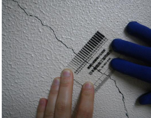
【構造躯体のひび割れ位置等を確認】
