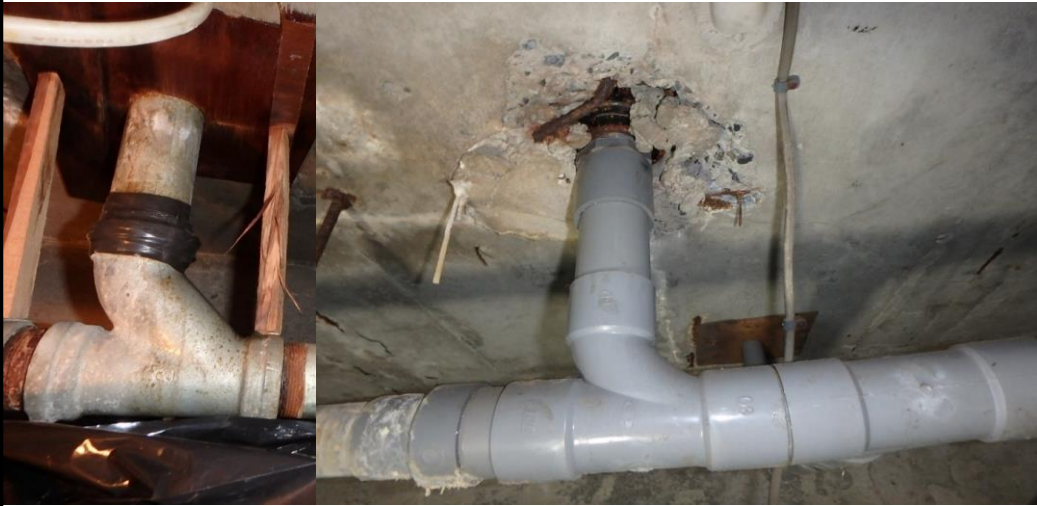
浴室防水が切れて漏水 生活出来ない
