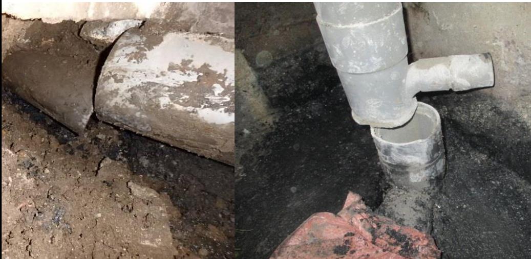
排水管の損傷、漏水
