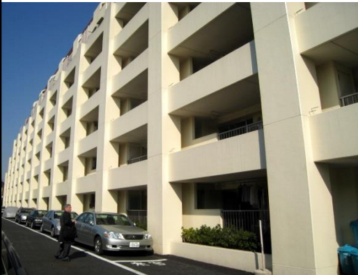
他事例の写真 マンションのバルコニーの先端にフレーム を設置した例 (改修後)
