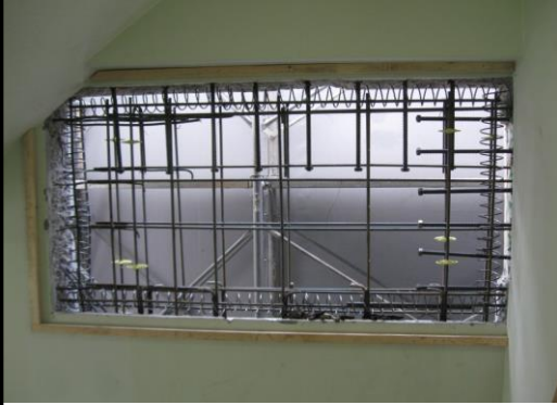
他事例の写真 階段室にあった窓を鉄筋コンクリートで塞ぎ、耐震壁した例（改修中）
