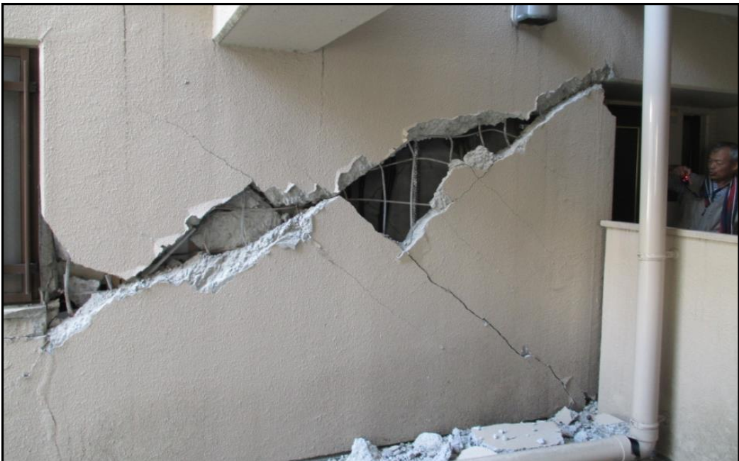
非耐震壁の損傷熊本地震
