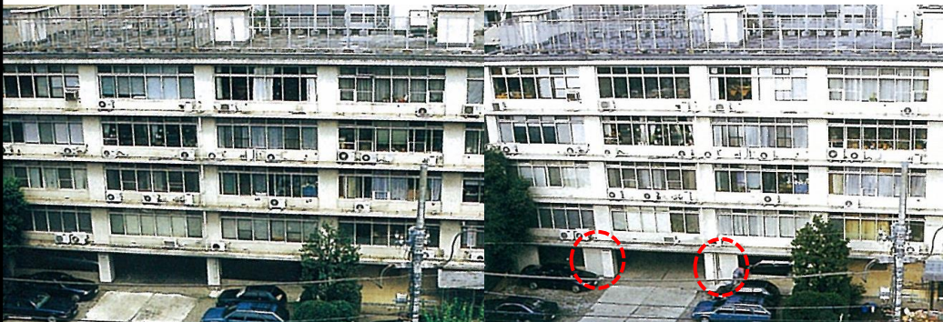
他事例の写真 1階のピロティに袖壁を設置した事例（改修前）
