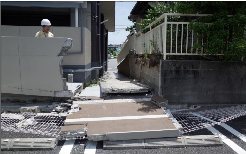
外構コンクリートブロック塀、擁壁の倒壊熊本地震
