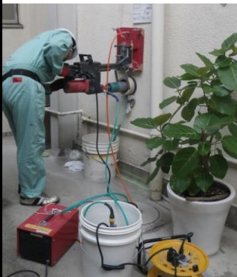
【コンクリート試験体採取の様子】
