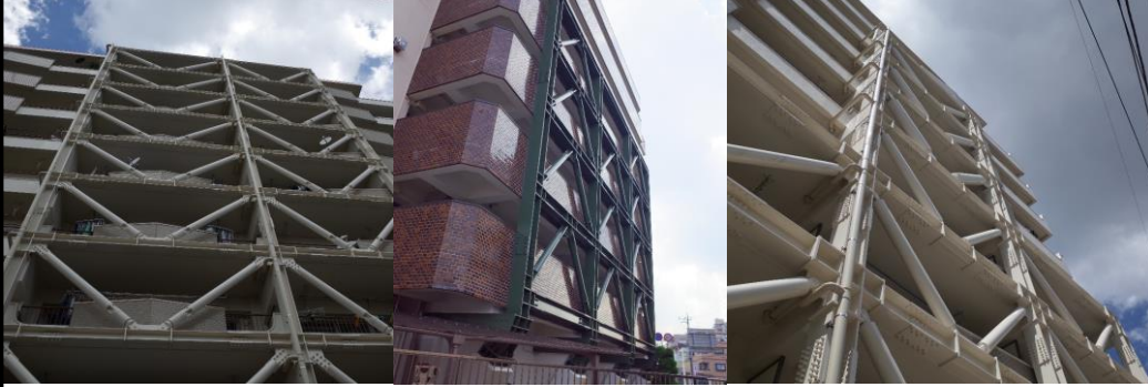
バルコニーの外側に 鋼管ブレースを設置した例
