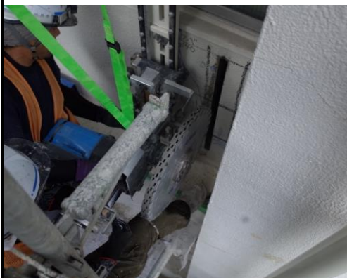
耐震スリットの施工写真
