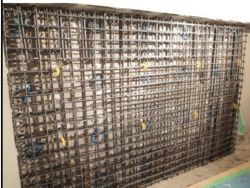
室内の壁を鉄筋コンクリートで厚くする （改修中）
