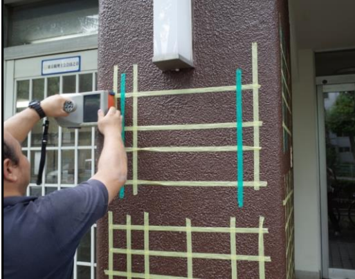
【柱鉄筋の配筋状況の探査調査】
