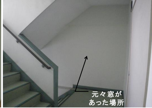
他事例の写真 階段室にあった窓を鉄筋コンクリートで塞ぎ、耐震壁した例（改修後）
