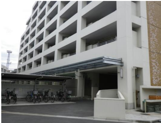
他事例の写真 マンションのバルコニーの先端にフレーム を設置した例 (改修後)
