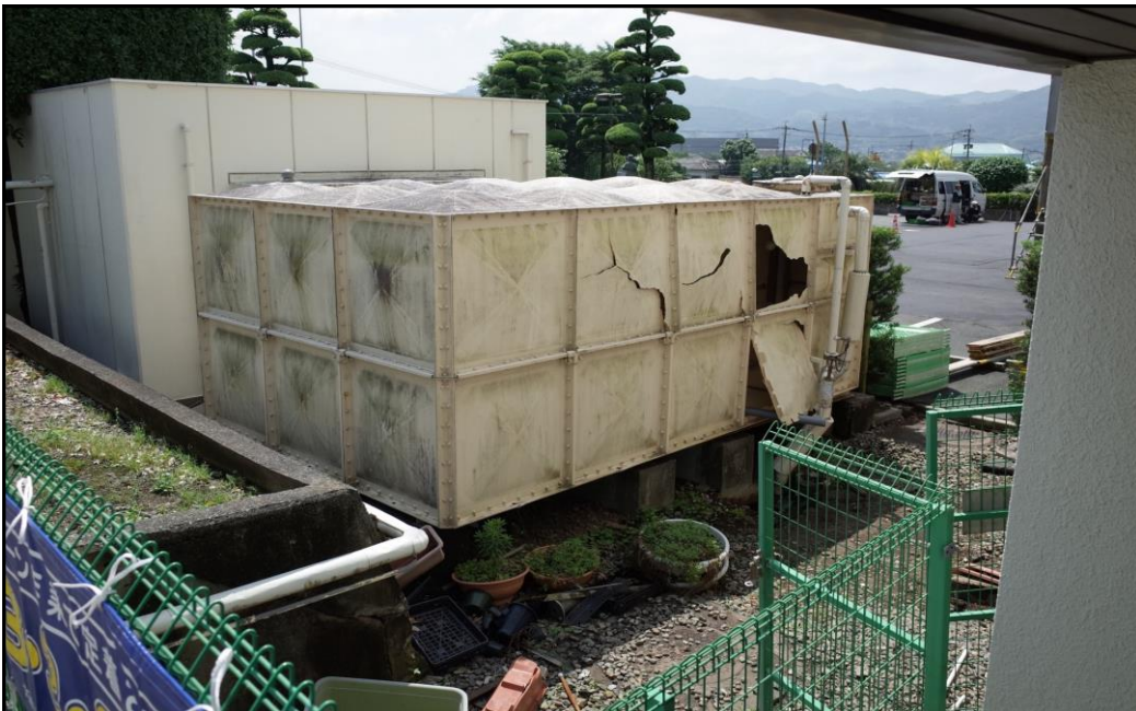
受水槽の破損熊本地震
