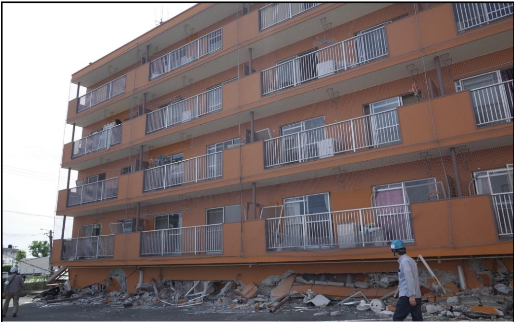
ピロティ倒壊(旧耐震)熊本地震
