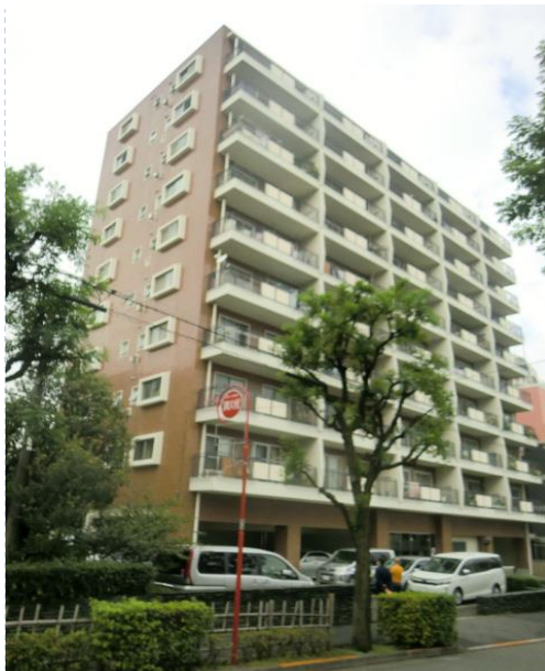
工事前 南道路側外観
