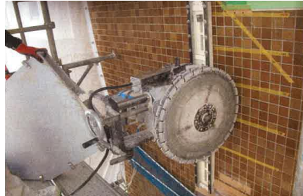
壁にスリットを入れる(粉塵・音の少ないアウト工法)
