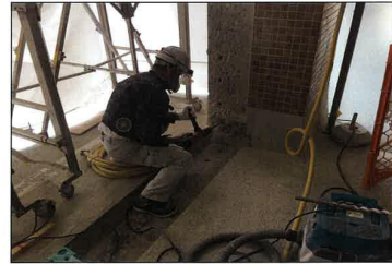
壁下地 鉄筋 研り出し
