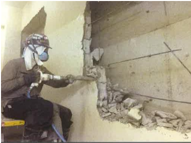
内側ブロック壁撤去
