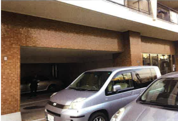
施工前 1階 ピロティ駐車場
