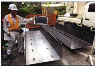
鋼板(9mm)工場検査
