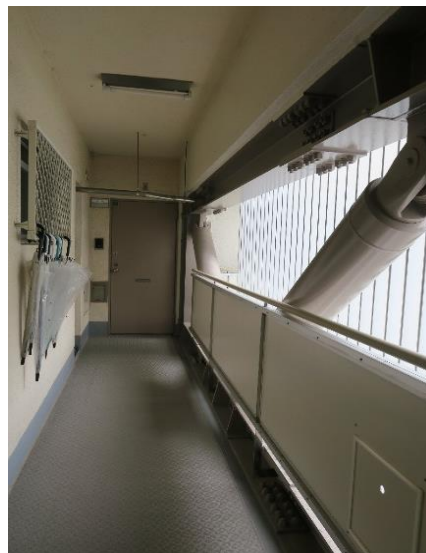
外廊下ブレース内観
