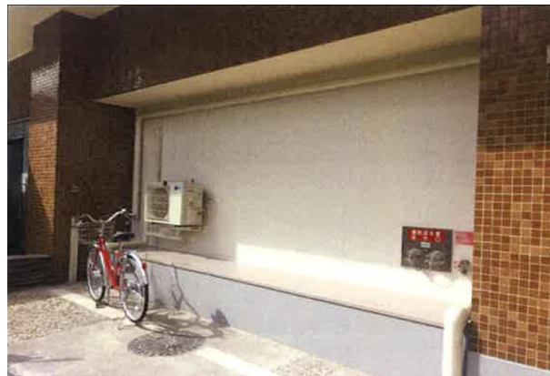
開口閉塞竣工外観
