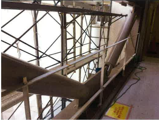
ブレース・手摺 取付
