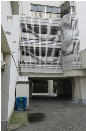
外廊下ブレース外観
