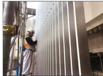
ルーバー取付
