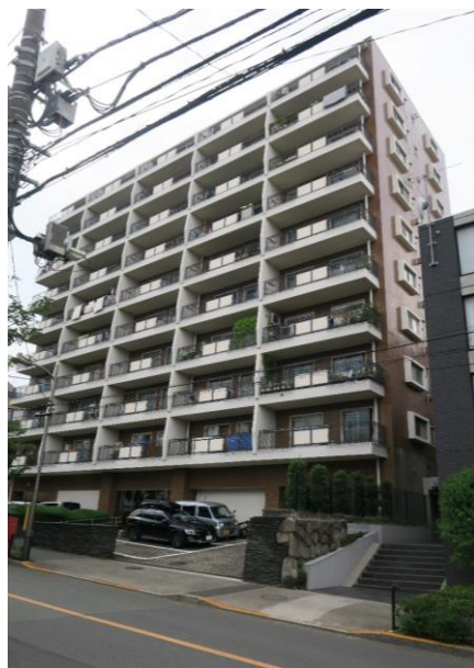
工事後 南道路側竣工外観
