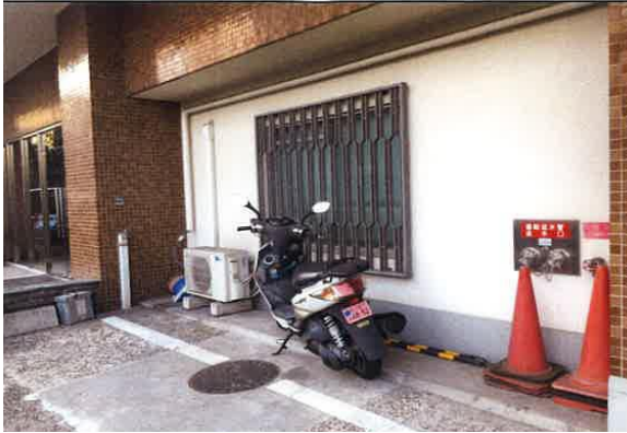
工事前管理室開口部外観
