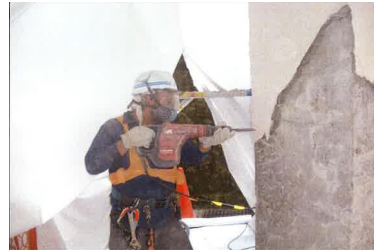
柱廻りモルタル撤去・目直し
