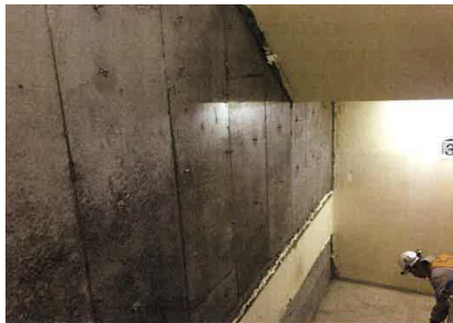
内壁コンクリート打設
