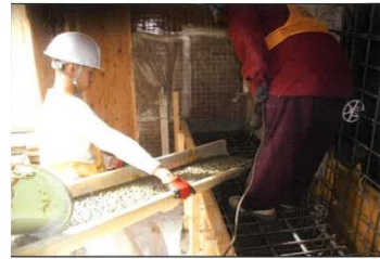
開口部鉄筋 研り出し
