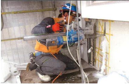
壁にスリットを入れる(粉塵・音の少ないアウト工法)
