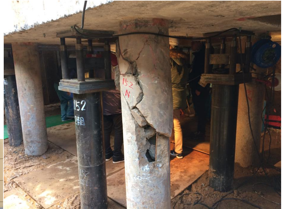
2018年2月復旧工事中
