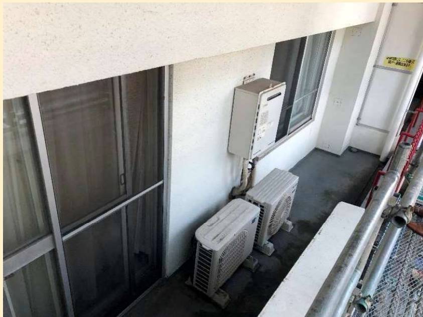
①工事着手前
