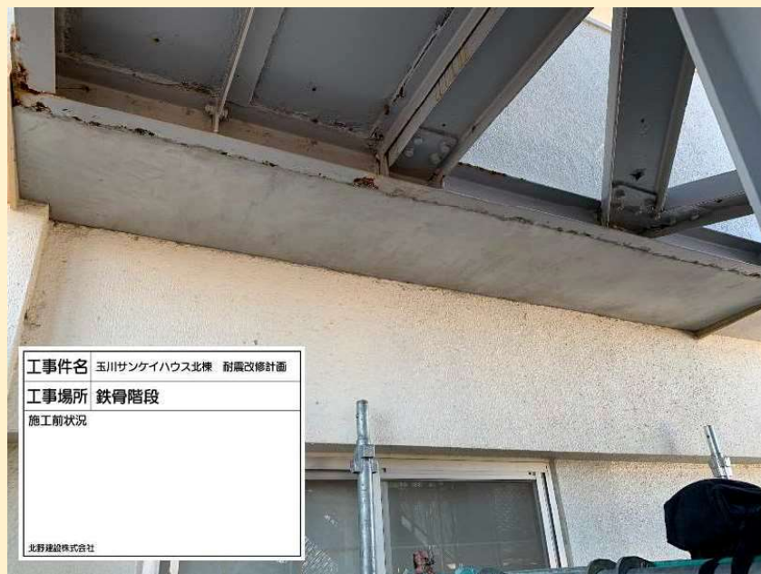
①工事着手前
