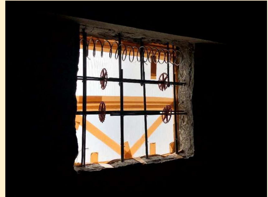
②工事中 (アンカー工事 完了状況)
