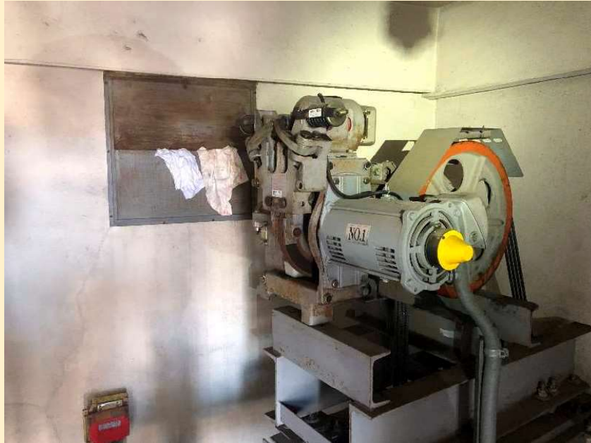
①工事着手前
