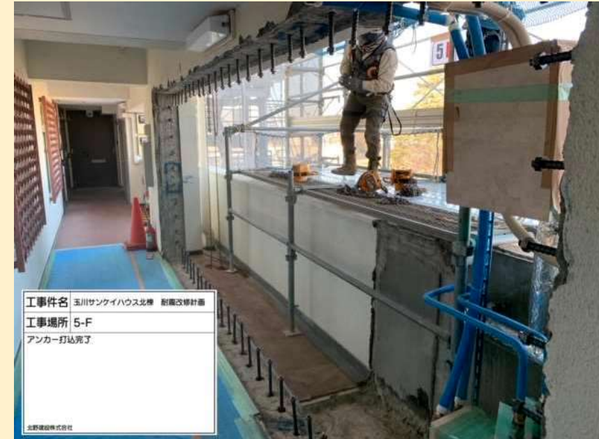
②工事中 (アンカー工事 完了状況)
