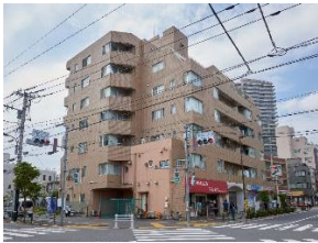
【改修前】建物外観
