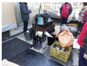
【改修工事中】陸屋根の防水改修
