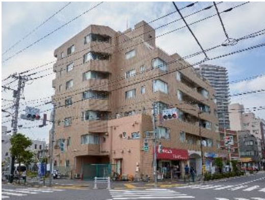
【改修前】建物外観
