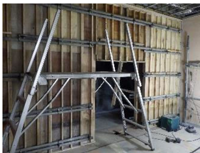
【耐震補強工事中】1階ビロティ
