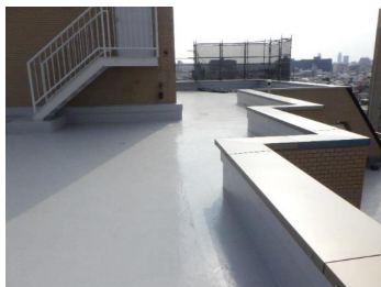
【改修後】パラペット天端の防水改修
