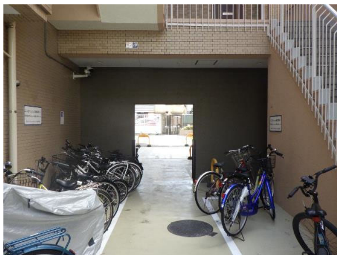
【改修後】1階ビロティ
