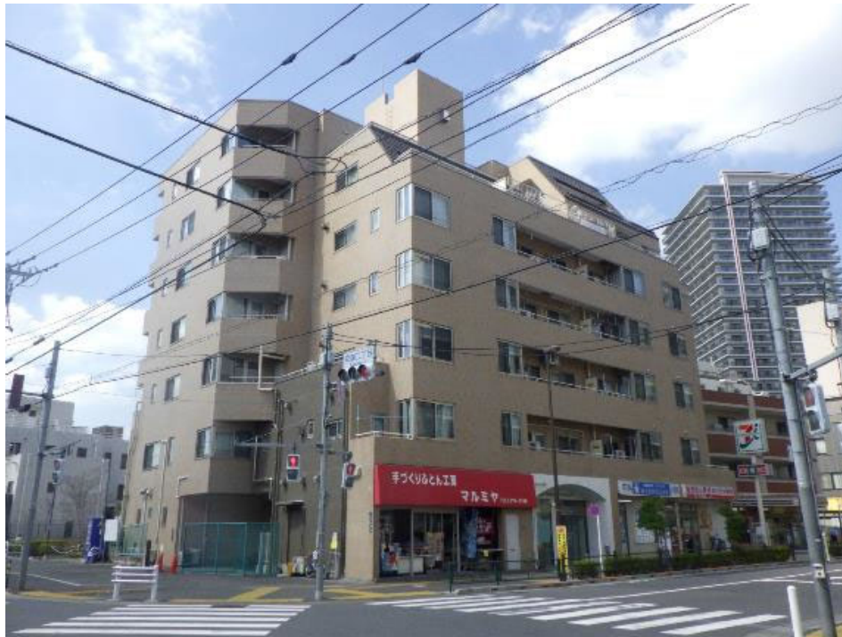
【改修後】建物外観
