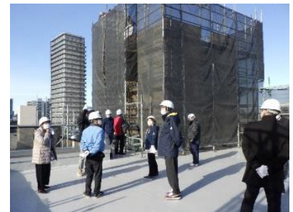
足場解体前の検査
