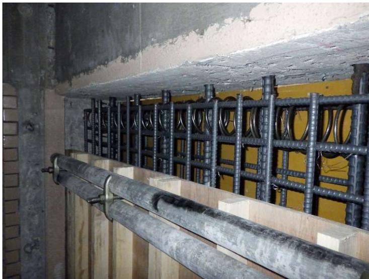
・耐震補強：開口付耐震壁 t220 新設
