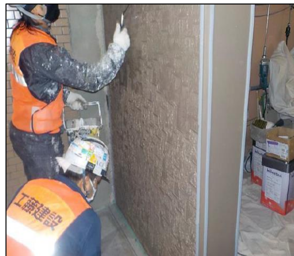
意匠性塗料による仕上げ塗装
