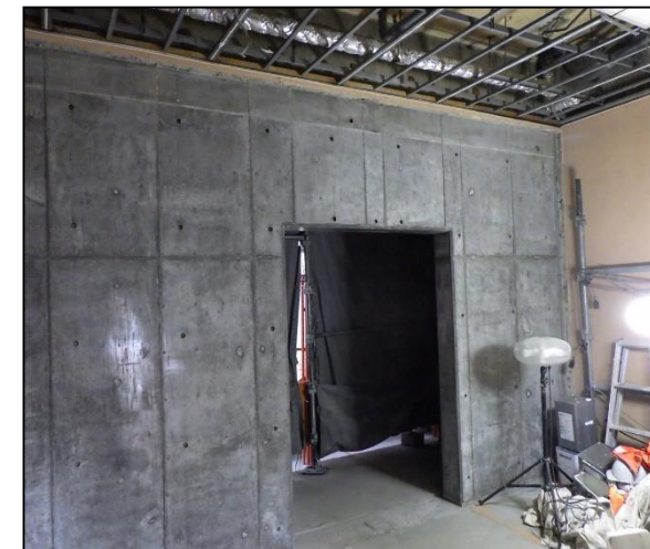
コンクリート型枠脱型後
