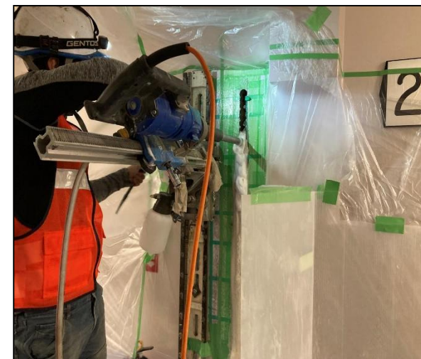
スリット削孔（AWAT工法）
