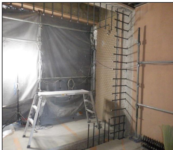
アンカーボルト打込み
