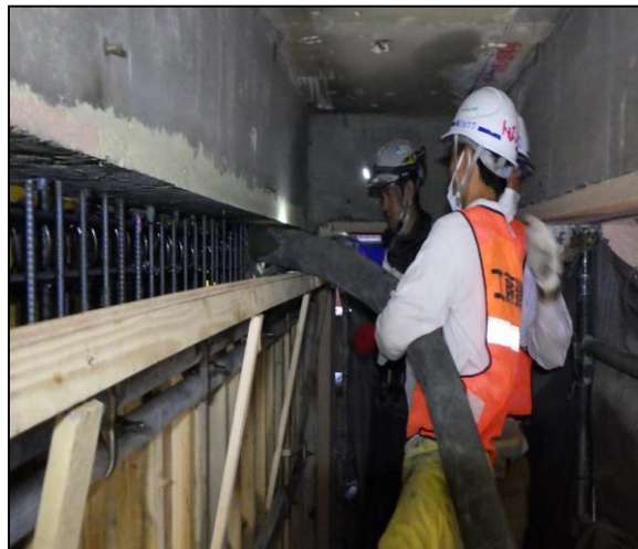
コンクリート打設
