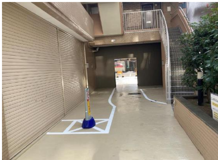
施工後(正面 東側)
