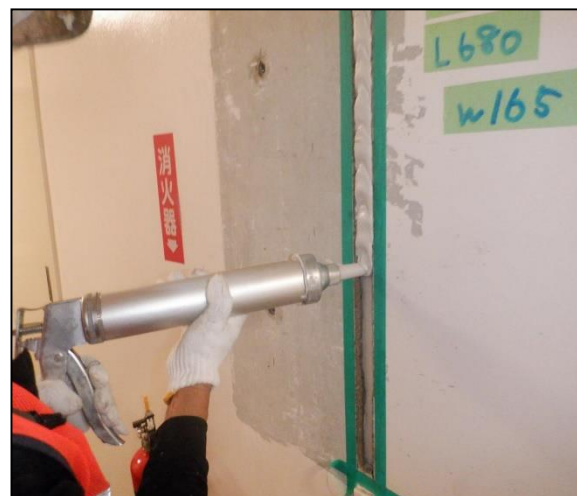
シーリング材充填
