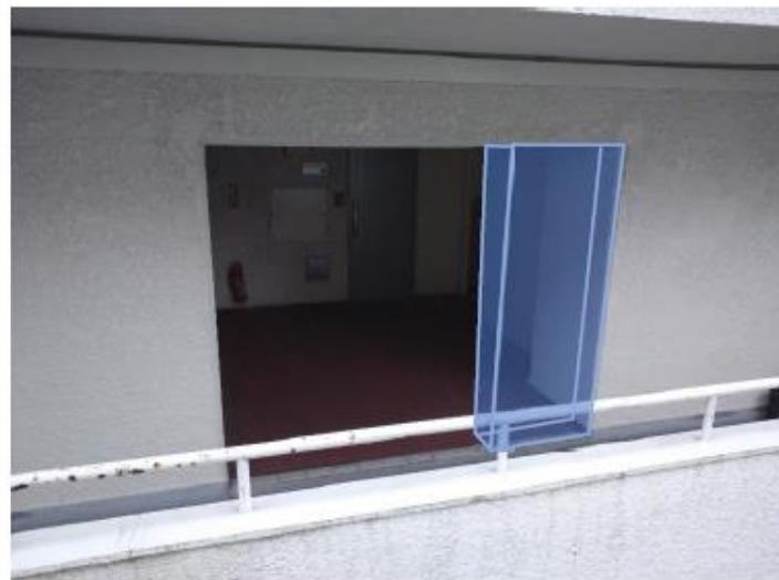
④ A階段 2階と6階：袖壁新設補強
