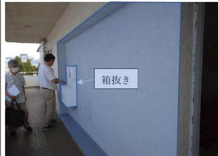
③ A階段 2階と6階：袖壁新設補強
