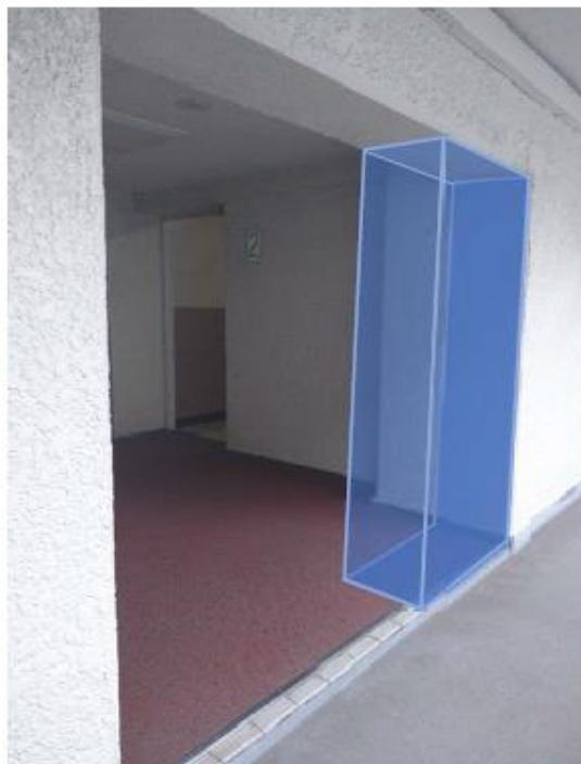
⑥ B階段 1階：壁増打補強
