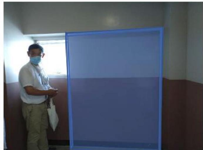
⑤ B階段 2～6階：壁増打補強
