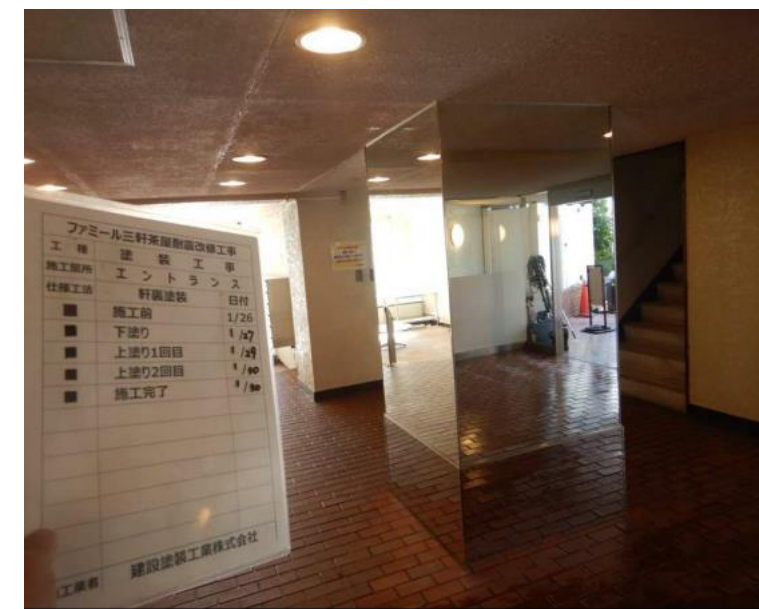
⑥施工完了
