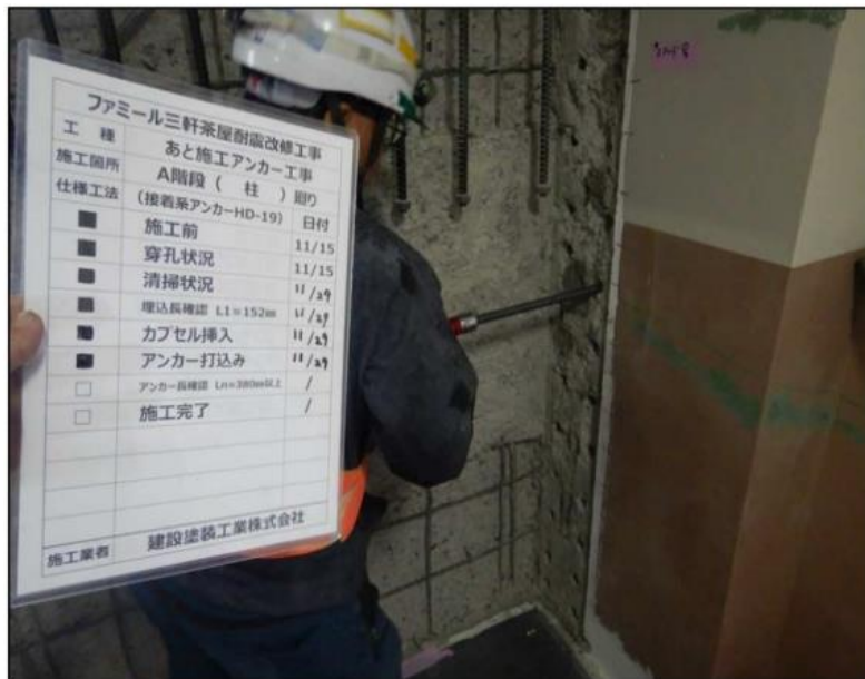
④アンカー工事
