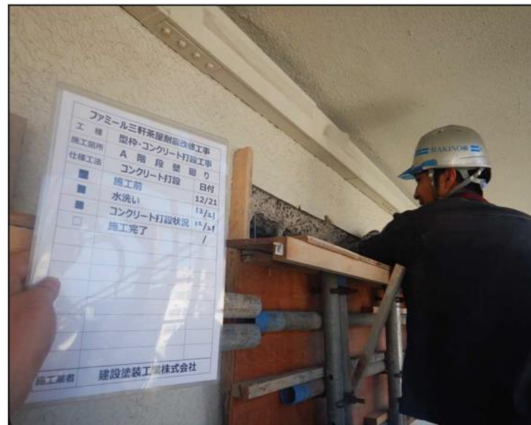
⑧コンクリート工事
