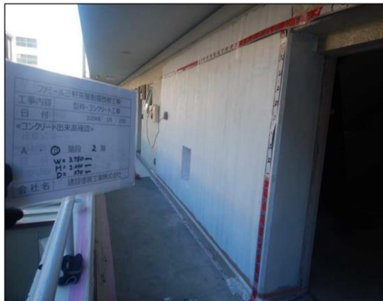
⑩コンクリート工事完了
