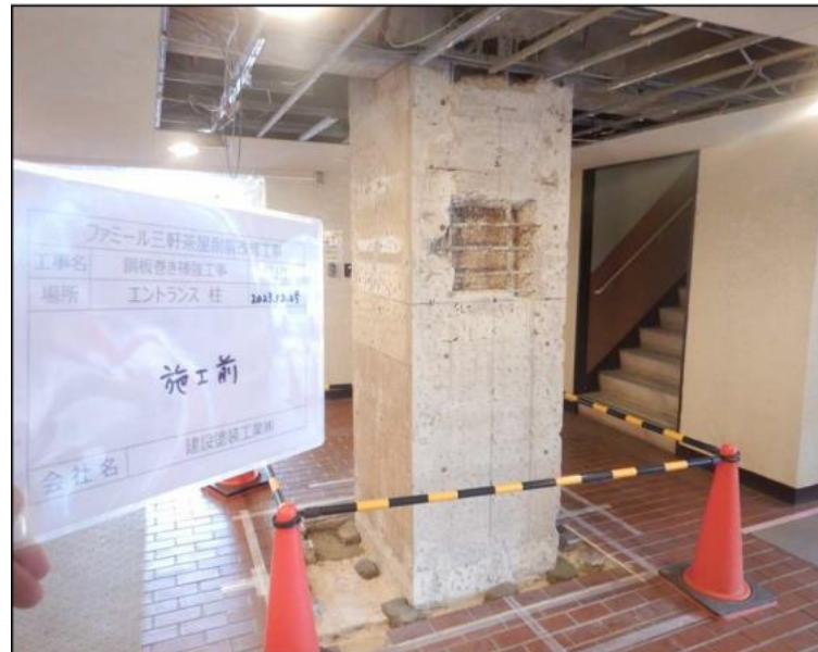
②仕上げ材撤去工事
