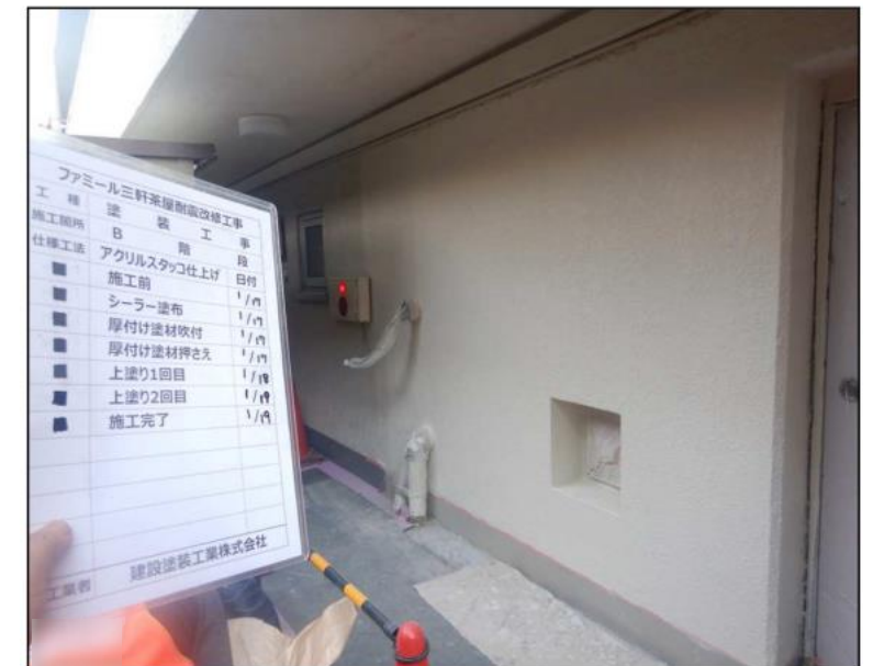
⑫施工完了
