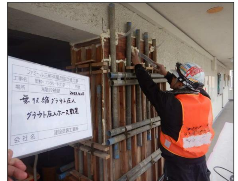
⑨グラウト工事
