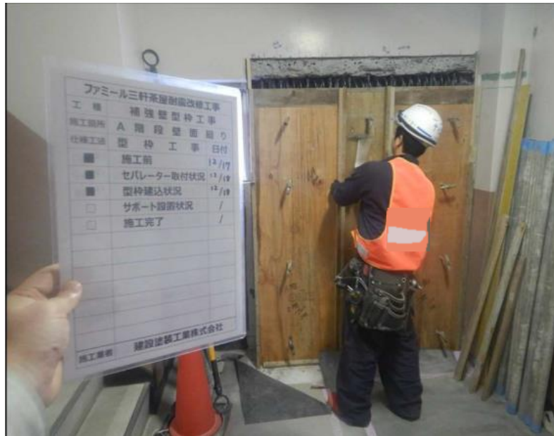
⑦型枠工事
