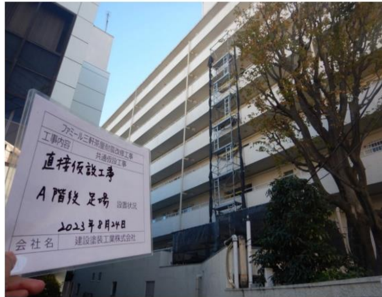
②足場工事
