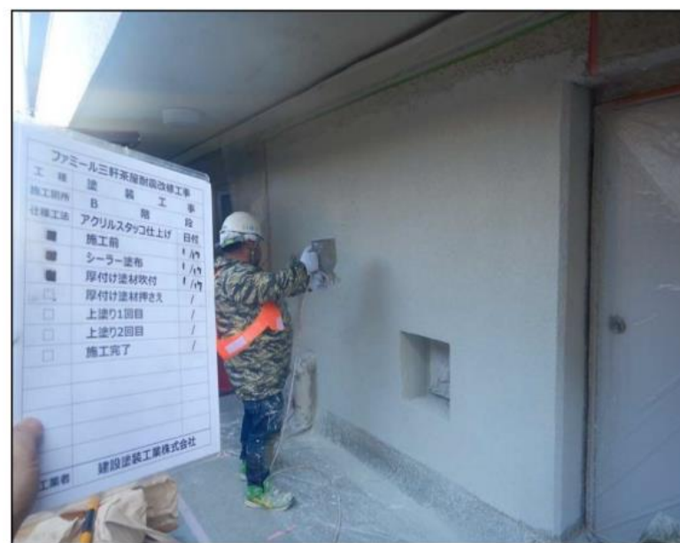
⑪塗装工事
