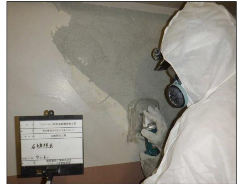
③仕上げ材撤去工事
