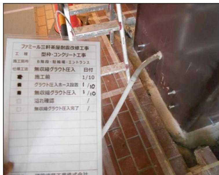
④グラウト工事
