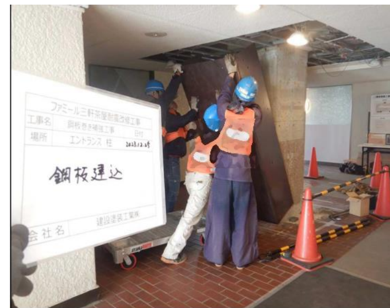
③鋼板巻き工事
