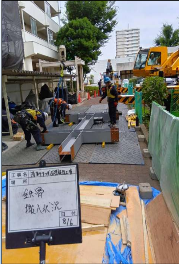
鉄骨建て方資材ヤード路面破損養生
