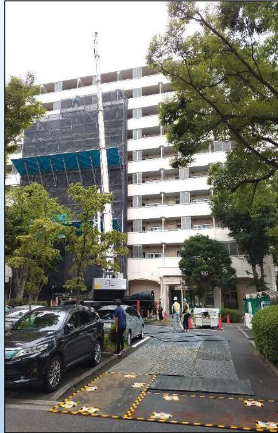
鉄骨建て方仮設ヤード路面破損養生
