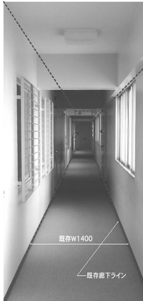
—共用廊下改修前—
