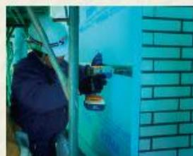
分別躯体が容易な非接着工法は、多様な外装材に対応し、気候に左右されない工事が可能
