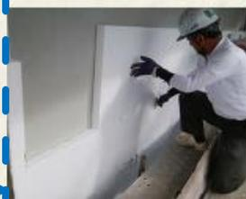
複雑な現場での施工が容易で、建物の形状、意匠における高度な要求にも柔軟性の高い対応が可能
