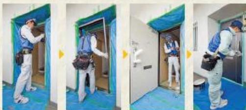
①下地取付 ②断熱玄関枠取付 ③扉吊り込み金物取付 ④枠回りリサイング
