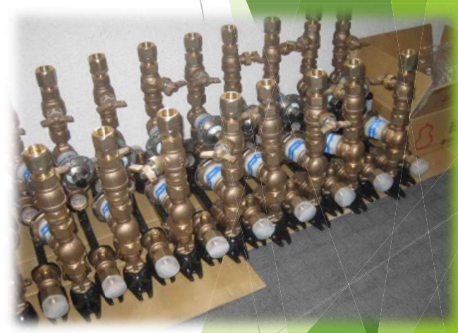
増圧直結方式への改修の際の、各戸に減圧弁設置工事の事例
