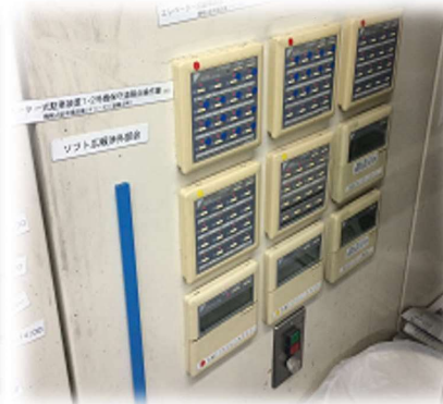
共用部分のエアコンの制御 * 特に、大規模なマンションの内廊下の空調
