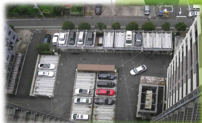
機械式駐車場(*ピットには多数の排水ポンプ)
