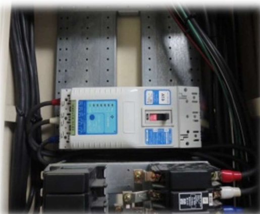
電子ブレーカーの設置(動力)
