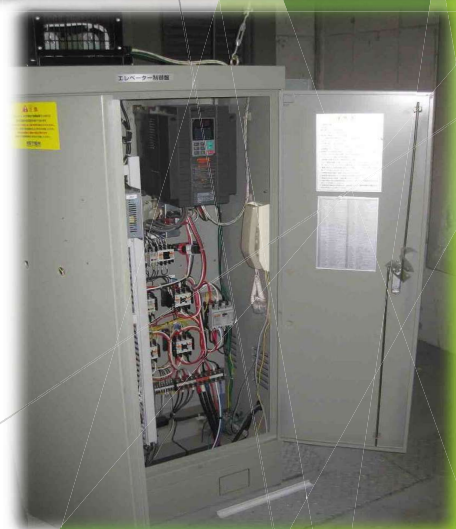
* 可変電圧可変周波数の交流電源で電動モーターの速度を制御
