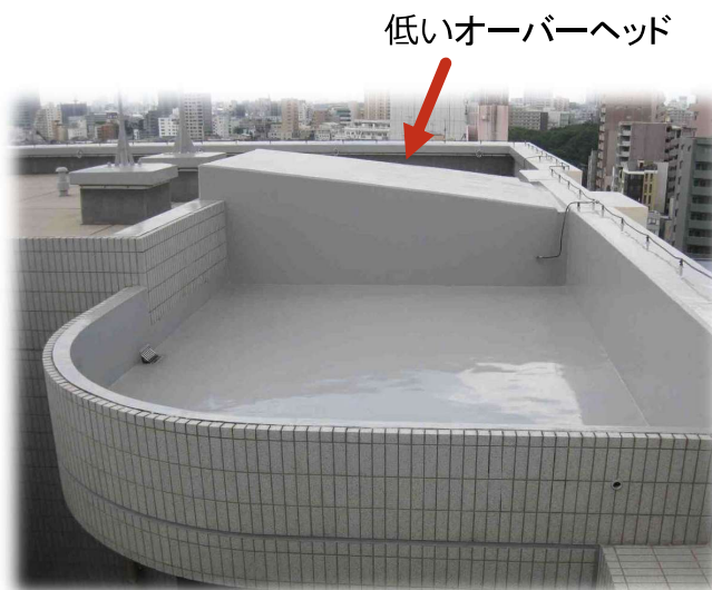
↑ * 巻上機が昇降路内部に収まるため、塔屋がなくても更新可能に
