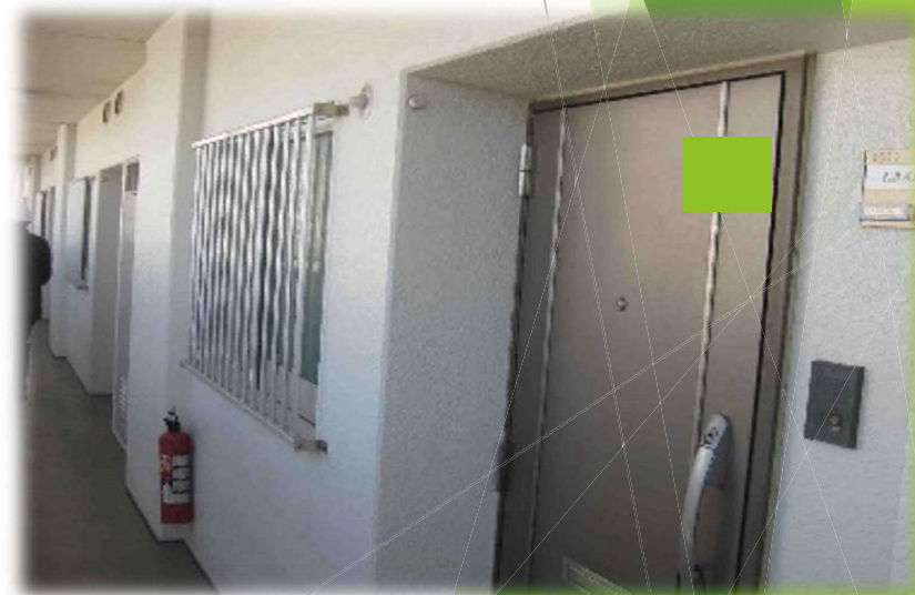
被せ工法による玄関扉改修の事例断熱性だけでなく、 防犯・防遮音・グレードアップ等々
