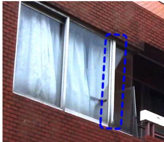
「方立て（ほうだて）」と呼ばれる窓のアルミ支柱。アルミ部材を組み立てて隙間をシールしているが、それが劣化しシールが切れ、雨水が入り込む（室内漏水被害）。日当たりがよい場所ほど紫外線で劣化。
