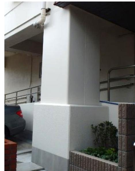
柱の中の鉄筋が外にはらみださないようにする補強
