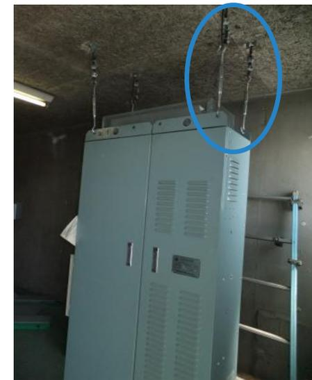
制御盤の転倒・移動防止
