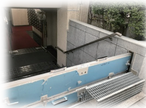
◀エントランスの様子 （止水板設置後）
