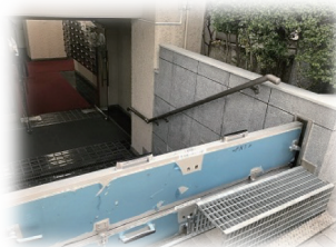
◀エントランスの様子 （止水板設置後）
