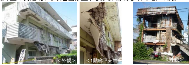
2階の廊下部分が崩落した事例
