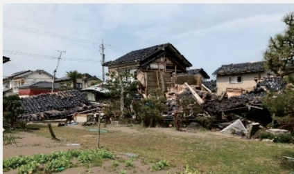
地震の揺れと津波と液状化によって木造家屋が軒並み倒壊している。
