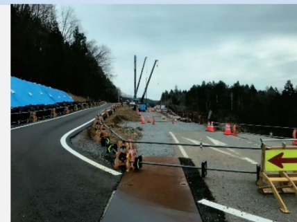
志賀町の国道。道路が崩落した箇所の仮設迂回道路と本復旧工事が並行して行われている。(2024年4月1日)
