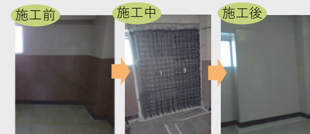
壁増打 西側階段室内の壁 壁の厚みを増して補強
