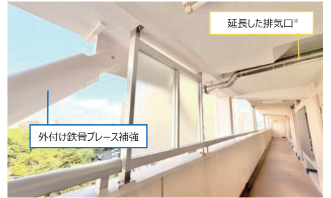
ブレース補強部分(4号棟 共用部廊下) ※補強部分との干渉により延長した排気口
