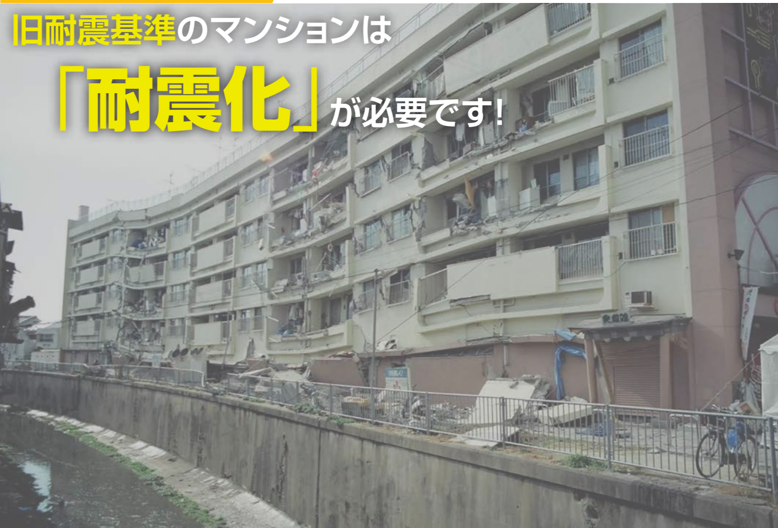
平成7(1995)年1月17日阪神・淡路大震災(神戸市)旧耐震基準の5階建てマンションで、1階に公設市場があった。1階中央部分から崩壊。
