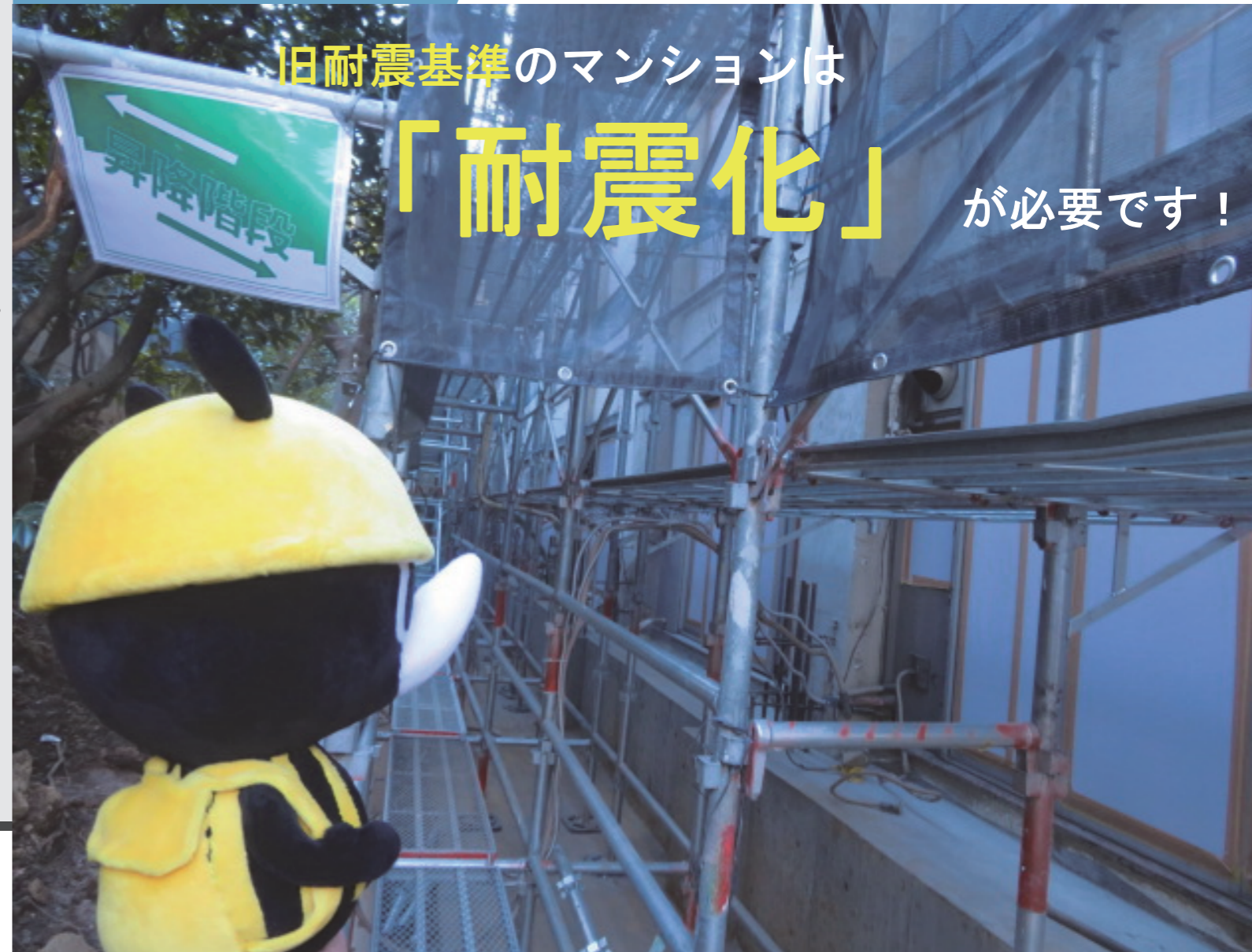
代官山コーポラスの耐震改修現場を防サイくんに訪問してもらいました。詳しくは裏面をご覧ください！
