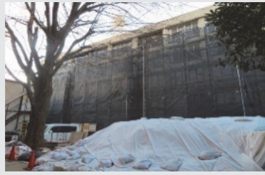
外付けフレームの取り付け工事の状況
