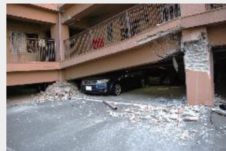
図2: 1階ピロティの崩壊 (熊本地震) (写真提供: JASO)
