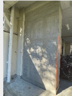
袖壁を設置し、補強↑
