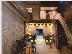
ピロティ部分に増設した耐震壁
