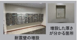
耐震壁の増設
