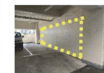
ブロック壁をコンクリート壁に
